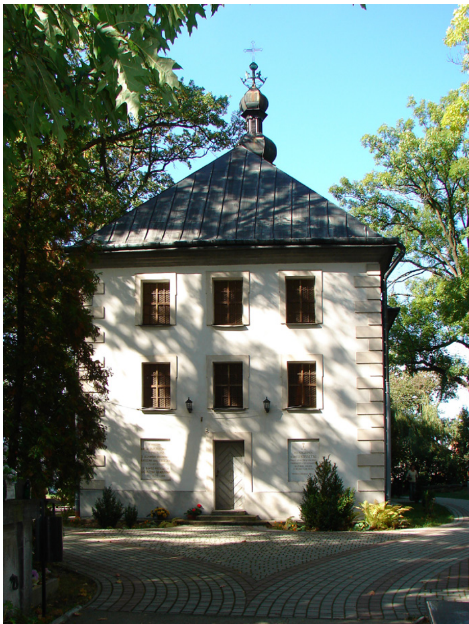
Il. 8. Szczepanów, kościół św. Stanisława – widok elewacji tylnej. Stan z 2007 roku; fot. Ryszard Mączyński
