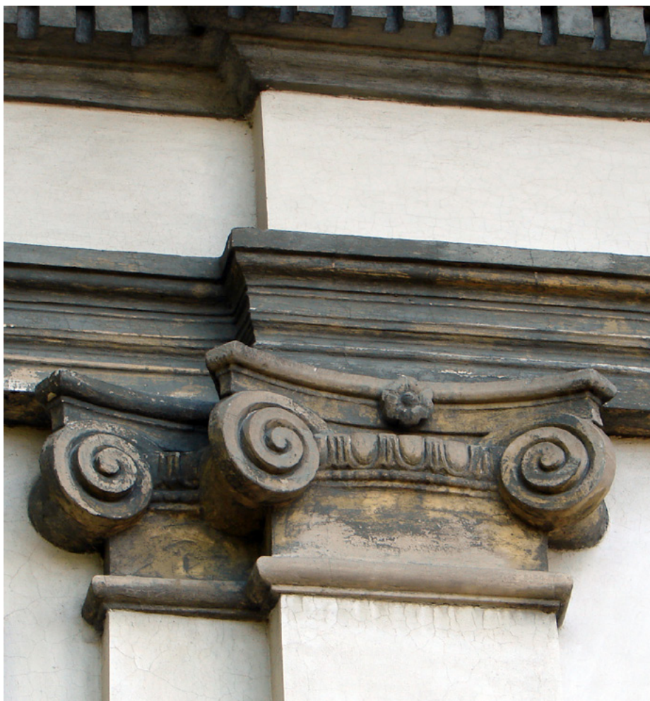
Il. 11. Szczepanów, kościół św. Stanisława – jońskie kapitele artykulacji porządkowej. Stan z 2007 roku; fot. Ryszard Mączyński
