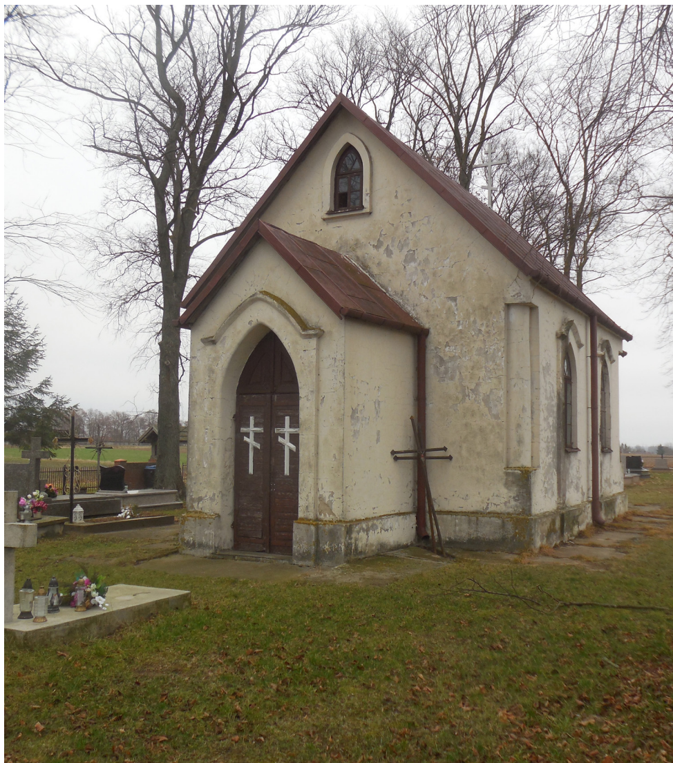
Fot. 5. Dawna kaplica cmentarna, a obecnie cerkiew prawosławna pw. Świętych Kosmy i Damiana w Kolechowicach. Widok od. pd.-zach. Fot. Jerzy Żywicki, 2025
