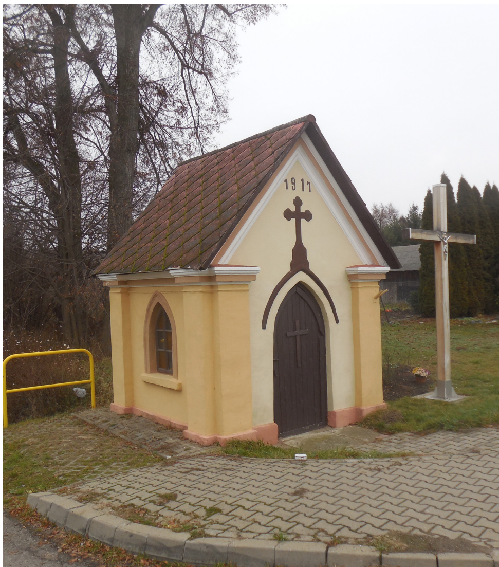
Fot. 8. Kapliczka przydrożna w Sieprawicach. Fot. Andrzej Cebulak, 2025
